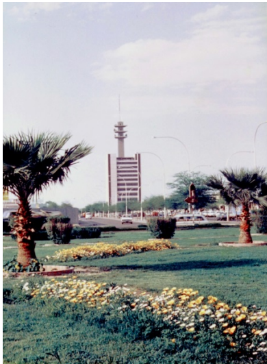
完成したテレコムセンター
